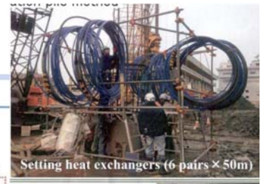
Polaganje izmjenjivača u armirano-betonske pilote
