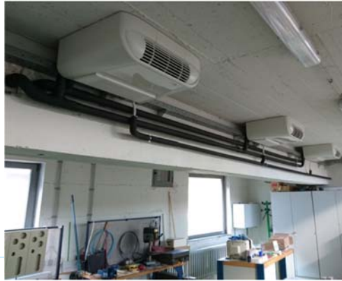
Dizalica topline Frigo Plus - Učinek grijanja 9,6 kW (B0/W45)
