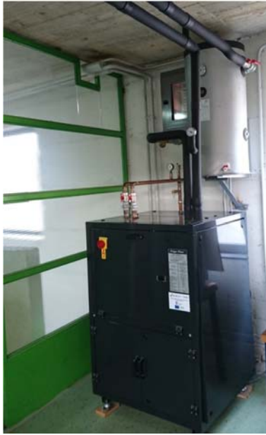
Dizalica topline Frigo Plus - Učinek grijanja 9,6 kW (B0/W45)
